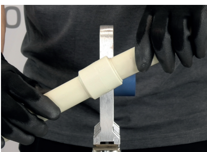
8. I början av kyltiden ska rör och rördel hållas fixerat, för att undvika separation, för fixeringstid se tabell
