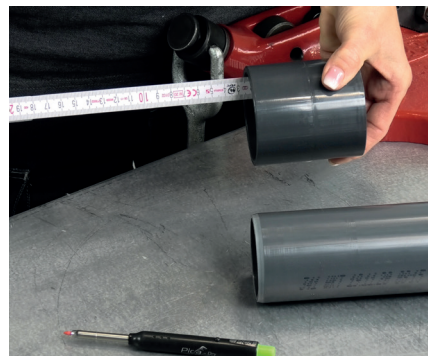
3. Mät rördelens insticksdjup och märk ut på röret
