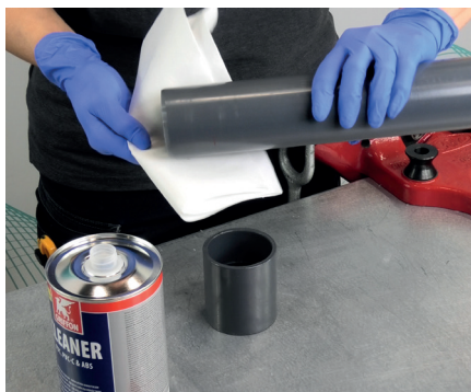
4. Rengör både rör och rördel med avsedd rengöringsvätska
