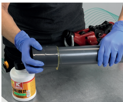
7. För in rör i rördel direkt efter appliceringen utan att vrida och vinkla delarna. Håll rördelen fixerad för att undvika att den trycks ut från röret
