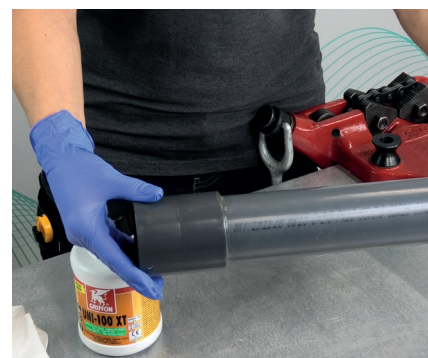
9. Låt torka. För full tryckbelastning enligt tryckklass eller innan tryckprovning (t ex 1,3 x PN) ska sista fog torka minst 24 h. För driftsättning med lågt tryck kan en torktid på 1h/1bar vid 20 °C användas
