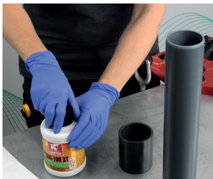
5. Rör om i limmet kontrollera att det inte finns klumpar i limmet. Om det finns klumpar får det inte spädas, utan ska kasseras och ny burk användas
